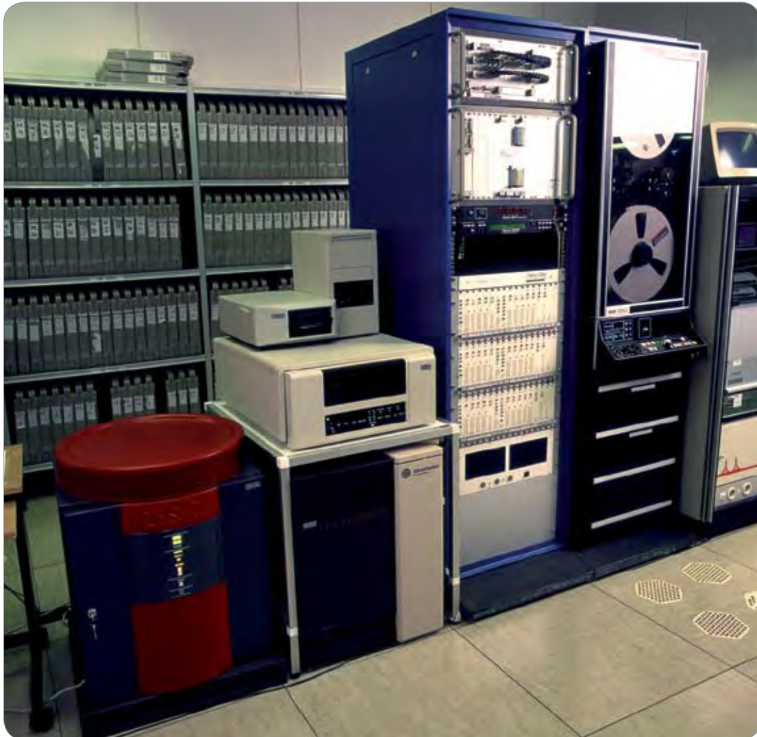
CESAR-installasjon ved Tromsø Satellittstasjon.
