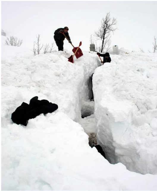
Figur 2.2 Graving av kanal i snøen for nedlegging av slanger fra bekken til prøvestasjonen til venstre, og plastslangene med påmonterte metallsiler til høyre.
