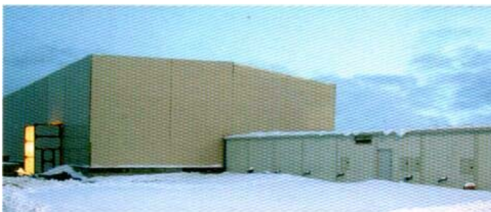
Фото 4. Интегрированный пункт переработки радиоактивных отходов и хранилище (ППП-РАО) на ФГУП «10 СРЗ» на стадии завершения строительства в декабре 2003 г.; слева на снимке – легкое модульное хранилище, справа – ММУ ТРО.
