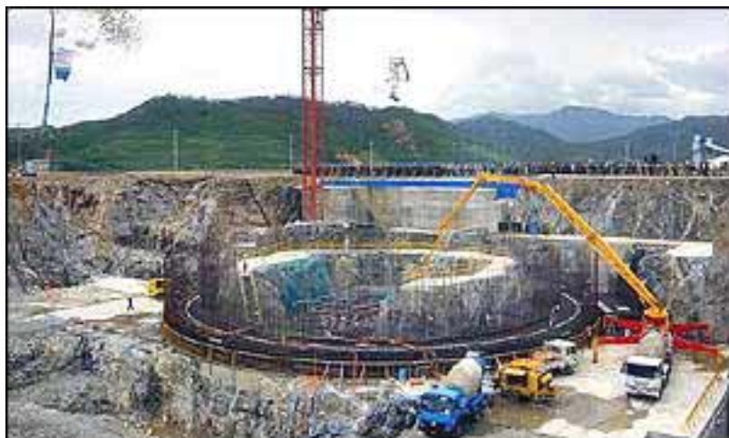
Figur 6 Konstruksjon av den første lettvannsreaktoren i Kūmho-chigu.
